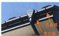
一般的な半円型、集水器がつき、吊金具が見えます。
