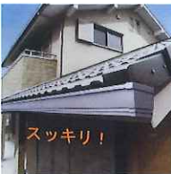
軒樋のジョイント部分の継手部材が露出しないよう内側に付ける内吊方式も見え目がスッキリとして人気です。
